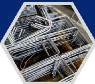
Thép gia công cắt-uốn
